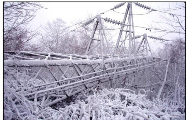
停電の原因になった倒壊した鉄塔↑
